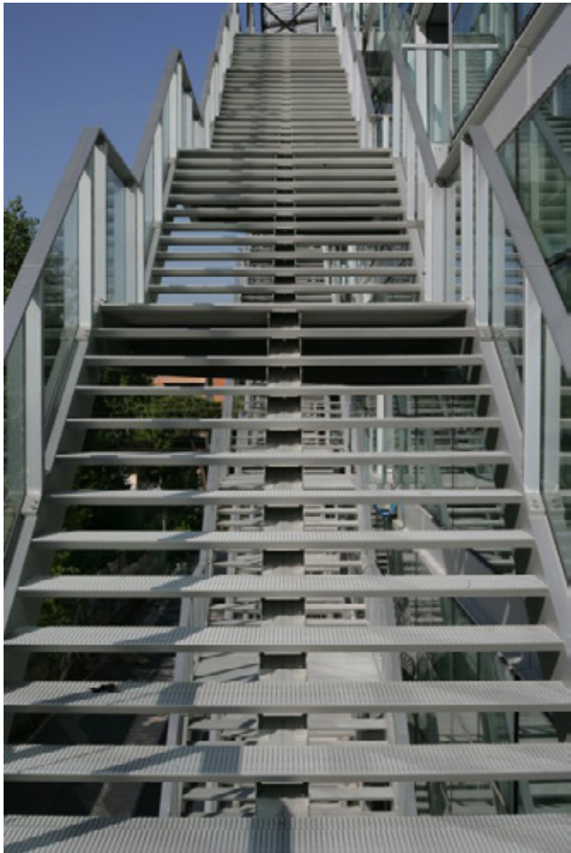
Fig 5.182 One of the aluminium staircases of the Palazzo dei Congressi di Riccione
